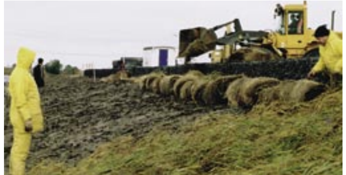
Oktober-december 2001, aanleg van de Aqua-Flora rietoever.
