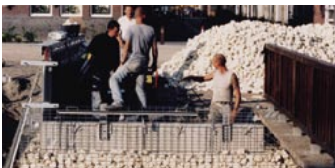
Mei-Juni 2004, aanleg schanskorf-(gevel)bekleding.
