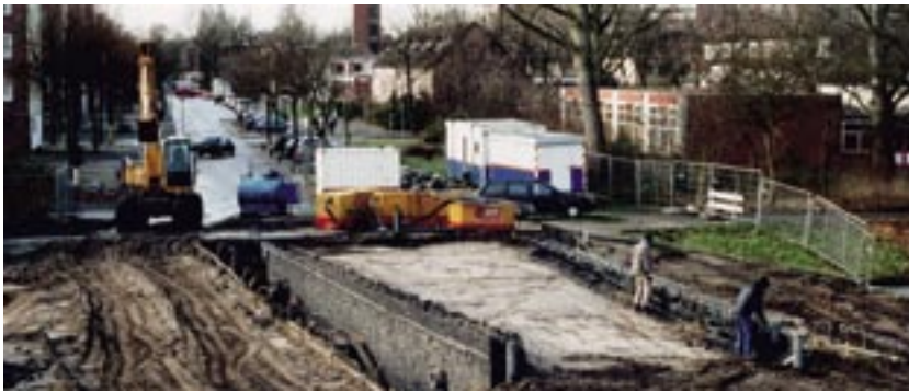
Januari 2005 schanskorf-constructie dam A
