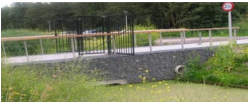
Mei 2005 schanskorf-constructie dam B voltooid
