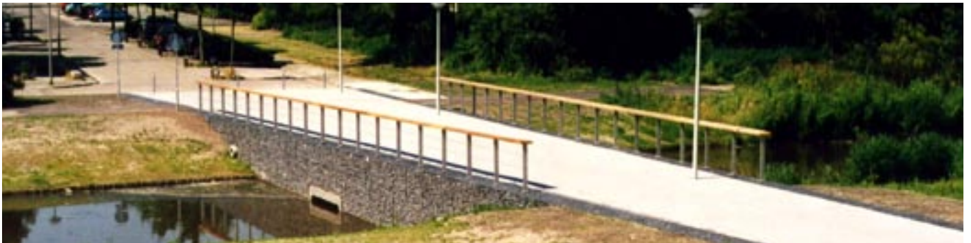
Mei 2005 schanskorf-constructie dam A voltooid
