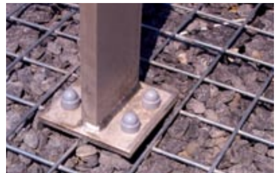
Detail hekwerk-bevestiging
