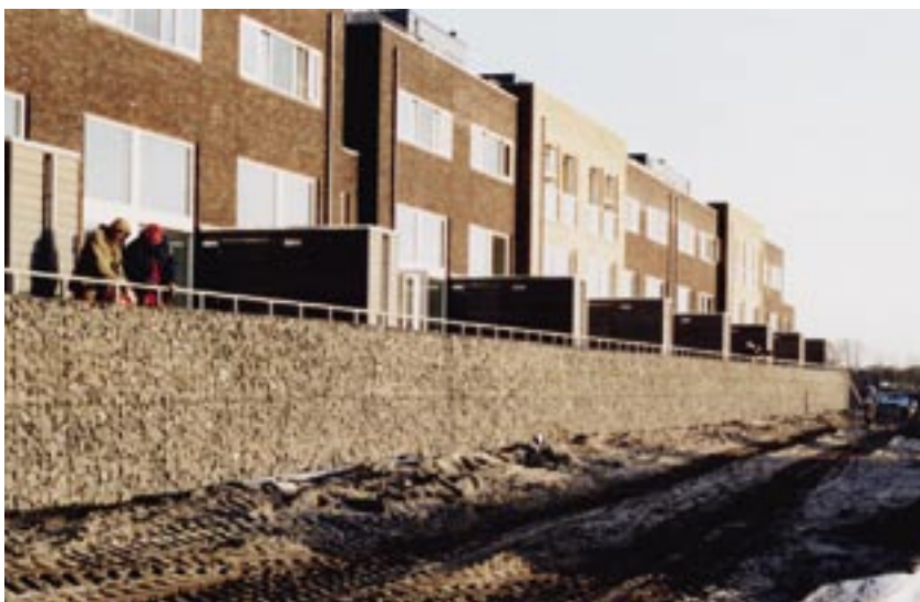
September 2004, aanleg schanskorf-constructie
