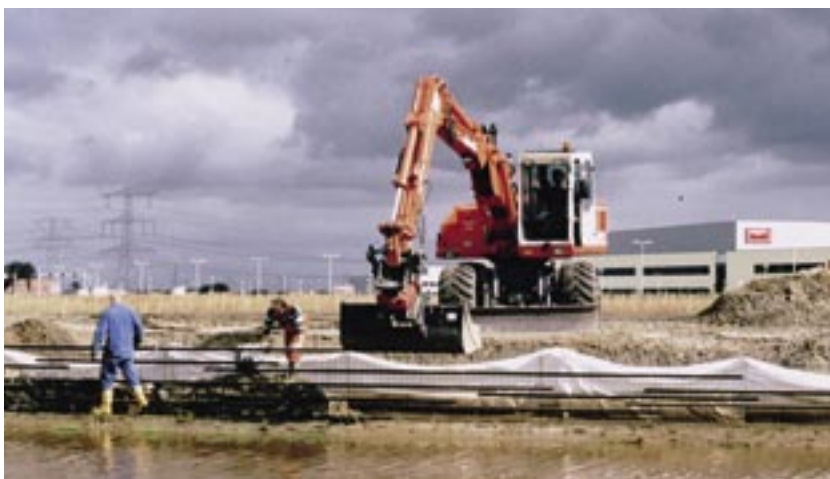
Juni-oktober 2001, de foto's geven een beeld gedurende de bouw van de grondkerende schanskorf-muur resp. bedrijfsterrinafscheiding.
