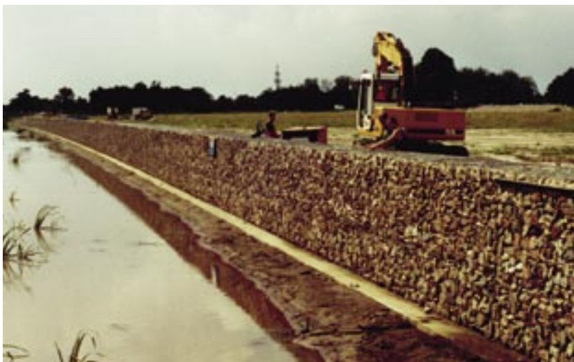
Juni-oktober 2001, de foto's geven een beeld gedurende de bouw van de grondkerende schanskorf-muur resp. bedrijfsterrinafscheiding.
