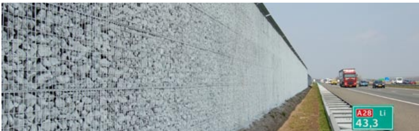
April 2008: het voltooide Clean Screen scherm, de lavasteen gecoat met titaniumdioxide
