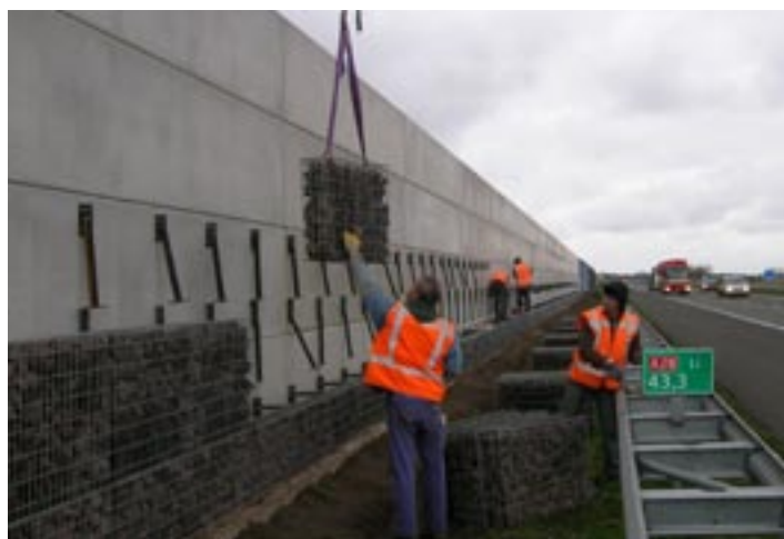
Maart 2008, aanleg 'Clean Screen' scherm: plaatsen van de schanskorven
