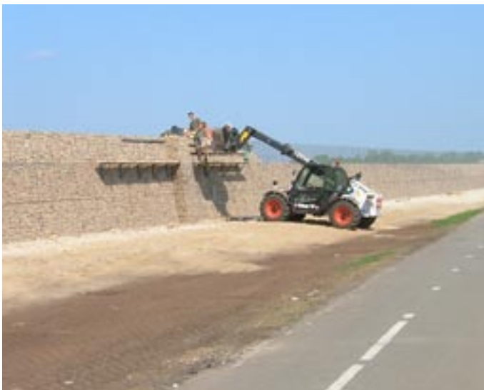
Juli 2006, aanleg geluidsmuur
