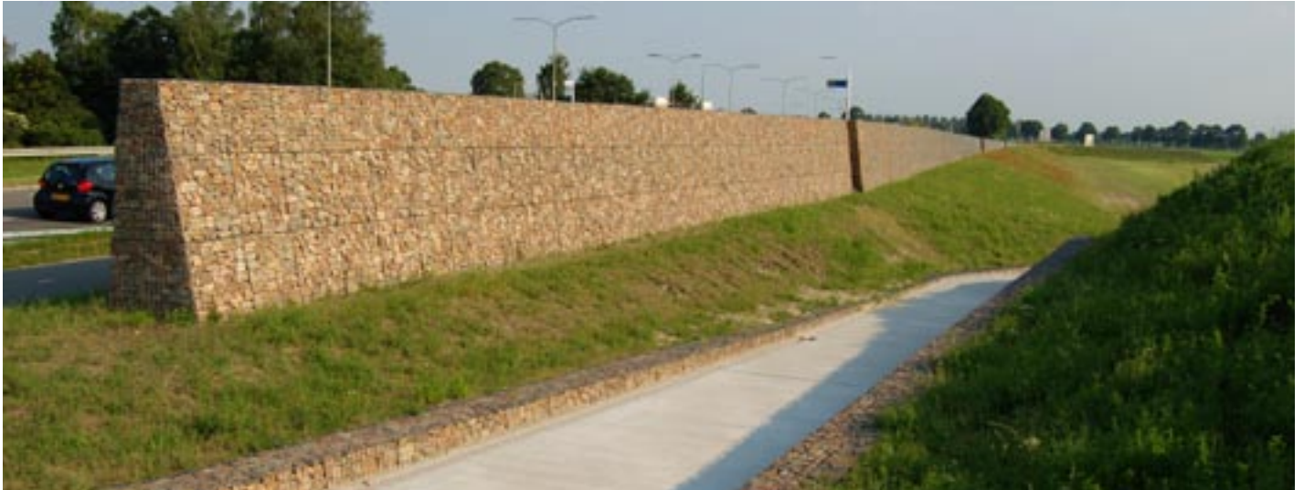
Mei 2007, de voltooide geluidsmuur vanaf de bewonerszijde
