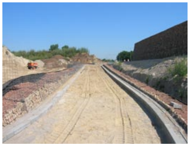
September 2006, bouw grondkeringen
