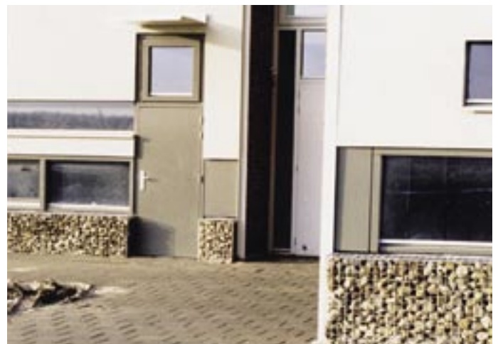
Om de stabiliteit van de schanskorven te waarborgen moeten zij verankerd worden aan de draagconstructie van het gebouw.
