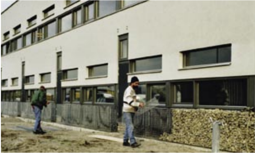
Oktober 1999, installatie van de schanskorven in de gevels. De wanddikte bedraagt 20, 25 en 45 cm, de steenvulling bestaat uit maasgrind.
