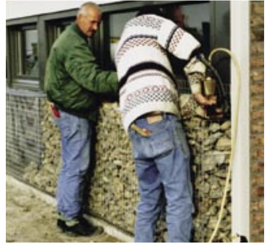
Oktober 1999, installatie van de schanskorven in de gevels. De wanddikte bedraagt 20, 25 en 45 cm, de steenvulling bestaat uit maasgrind.
