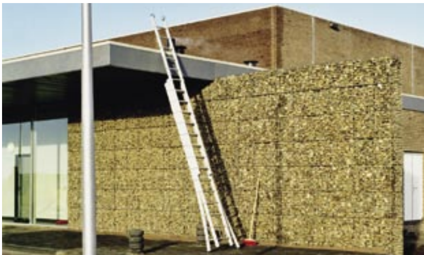
Om de stabiliteit van de schanskorven te waarborgen moeten zij verankerd worden aan de draagconstructie van het gebouw.
