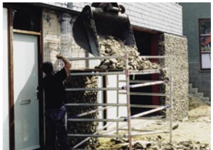
Juli 2001, bouw van de gevelafwerking in schanskorven.
