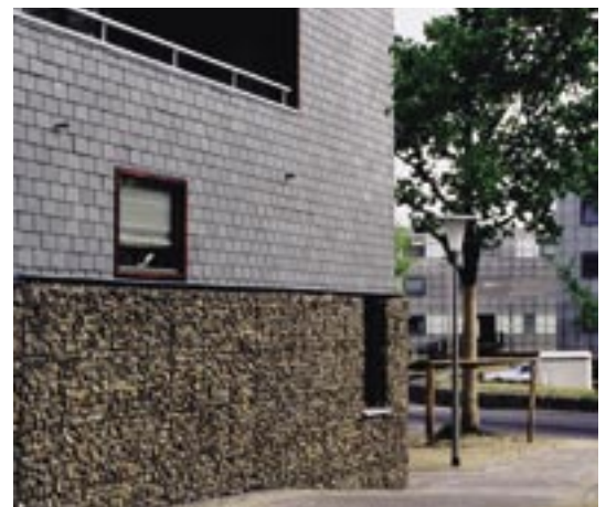
Juli 2001, bouw van de gevelafwerking in schanskorven.
