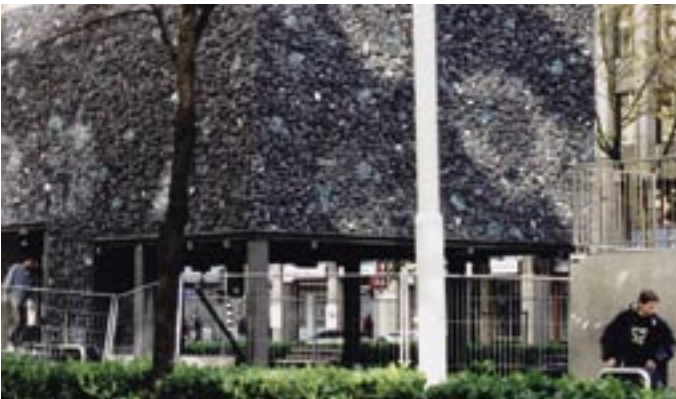
Juli 2003, het voltooide project met de schanskorf-gevels.
