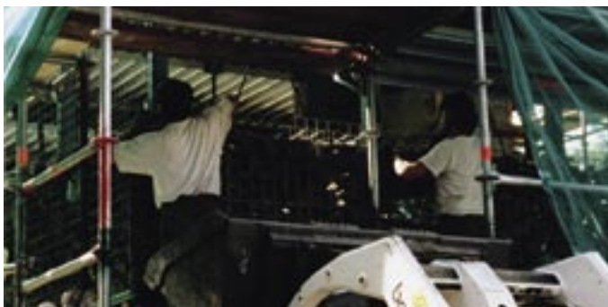
September 2002, bouw van de gevelafwerking in schanskorven.
