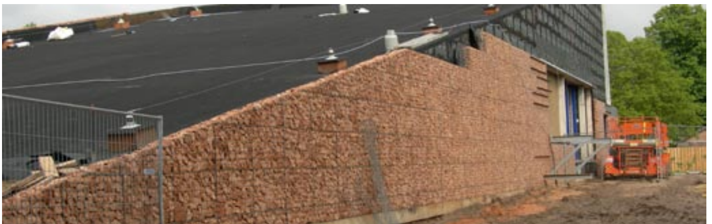
Mei 2006, de schanskorf-gevel werkzaamheden in volle gang
