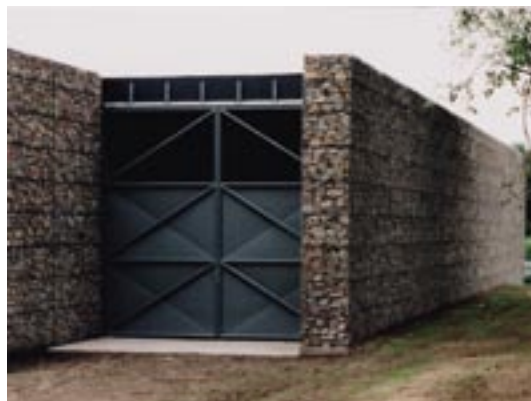
Detail van de lateiconstructie gereed
