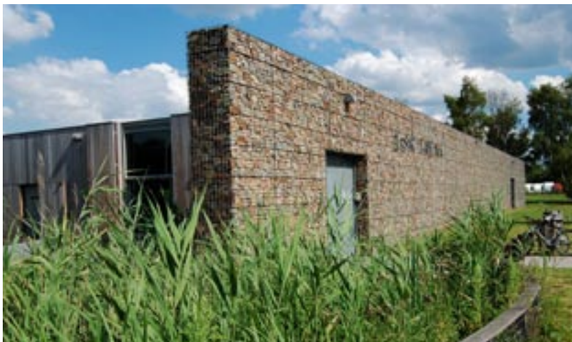
Maart-April 2004, bouw van de gevelafwerking in schanskorven.
