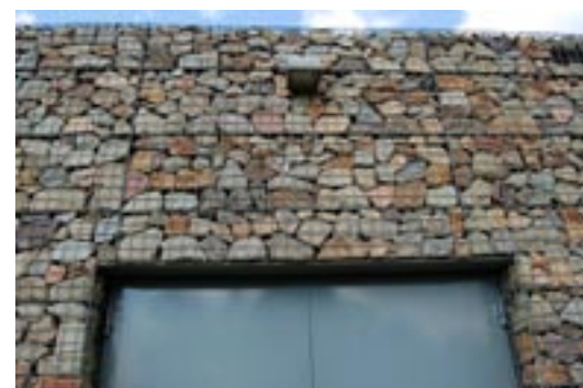
Detail van de lateiconstructie gereed
