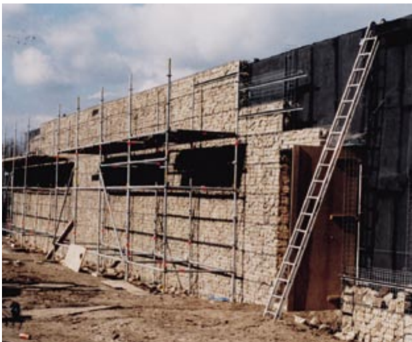
Maart-April 2004, bouw van de gevelafwerking in schanskorven.
