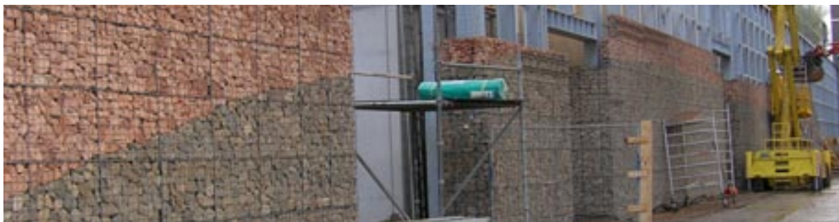
Oktober 2005, start bouw van de schanskorf-gevel
