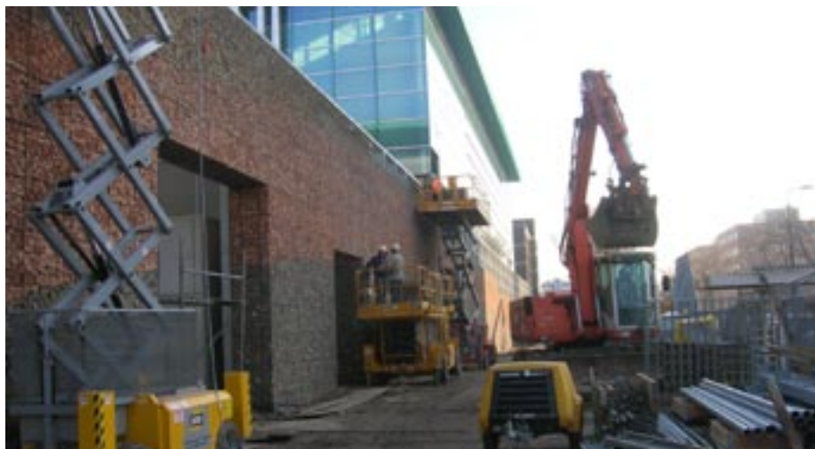
December 2005, werkzaamheden in volle gang
