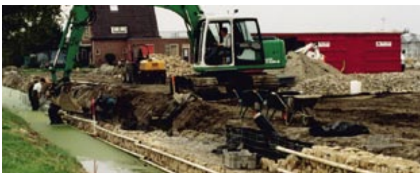
Oktober 2001 aanleg grondkering/oeverbescherming
