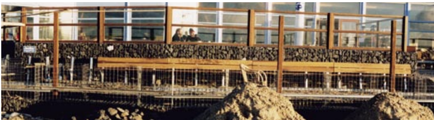
November 2003 aanleg grondkeringen en terras-afscheiding
