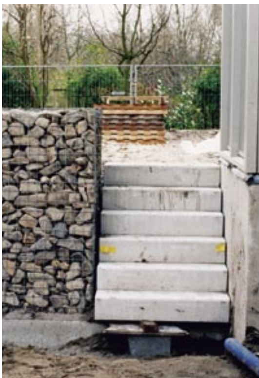
Detail aansluiting trap op schanskorf
