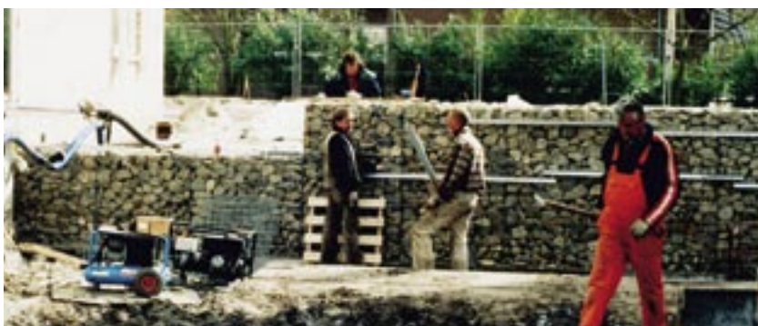
April 2004 aanleg schanskorf-constructies
