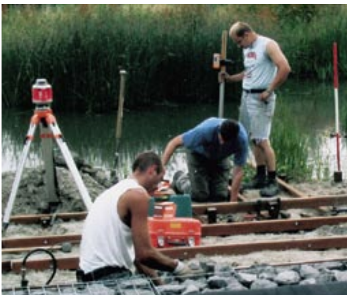
Zomer 2004 aanleg kleine grondkeringen en vlonders
