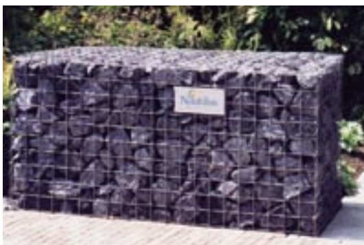
Juni 2004 grondkering: kalkbreuksteen vulling
