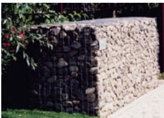
Juni 2004 grondkering: grof maasgrind vulling
