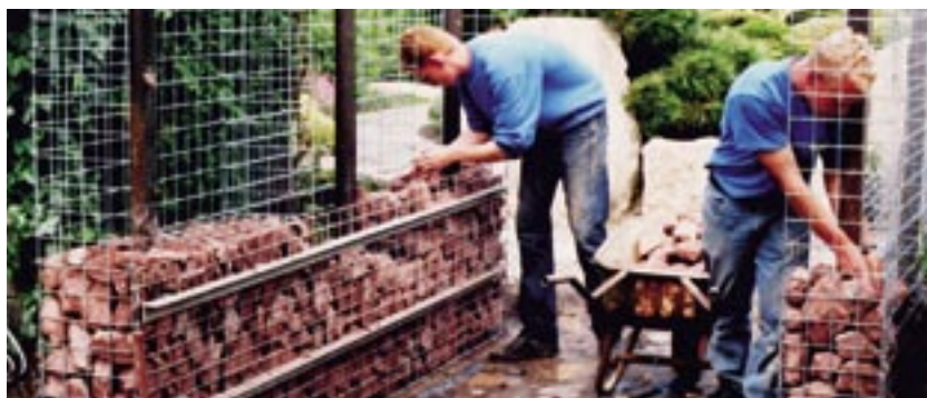
Juni 2004 aanleg erf-afschieding. Twee soorten steenvulling
