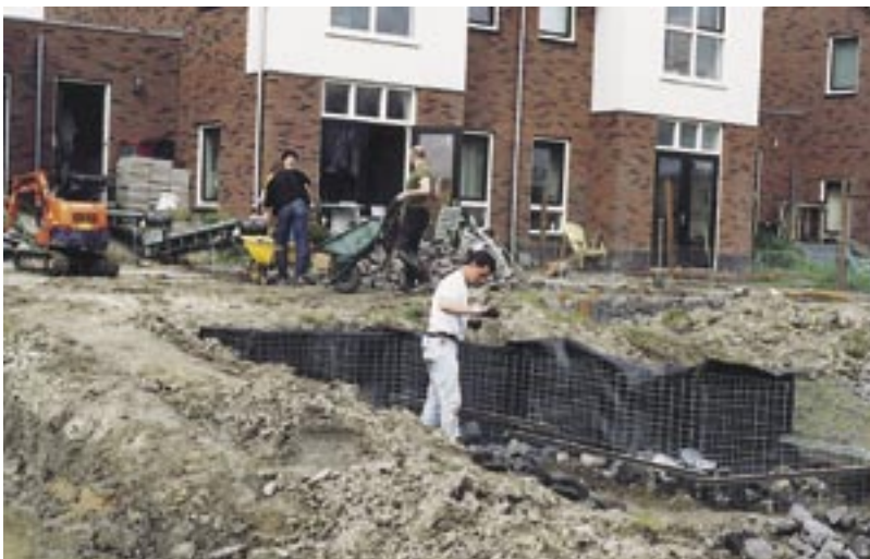
Mei 2005 - Aanleg grondkeringen & erf-afscheidings, steenaanvoer via transportbandje door de garage.
