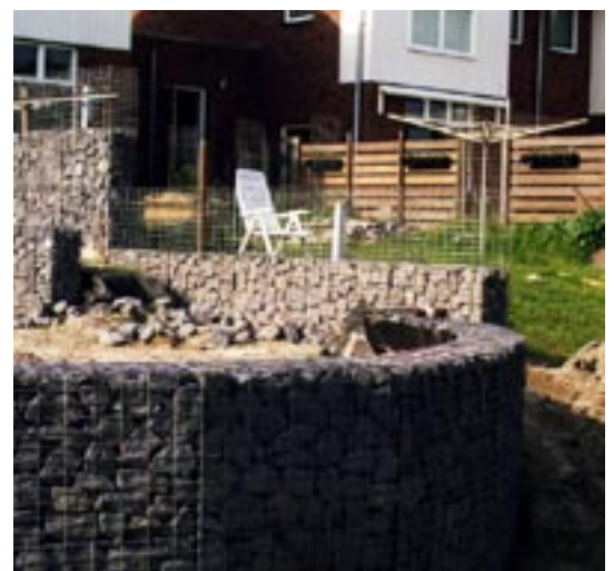
Mei 2005 - Aanleg grondkeringen & erf-afscheidings, steenaanvoer via transportbandje door de garage.
