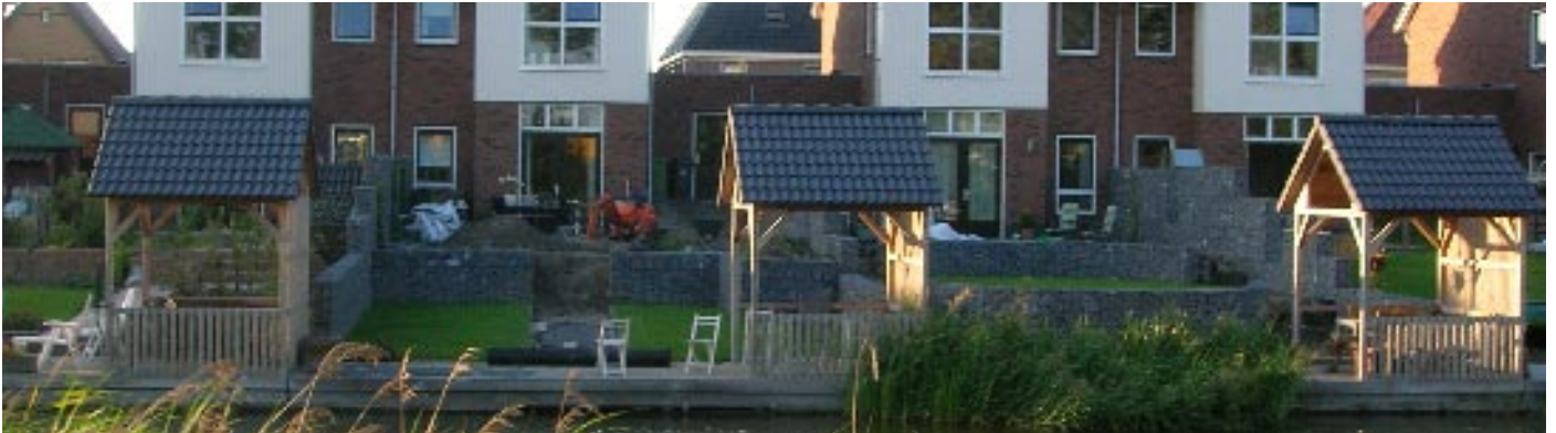
Overzicht voltooide schanskorf-erf-afscheidings en -grondkeringen in drie particuliere tuinen.
