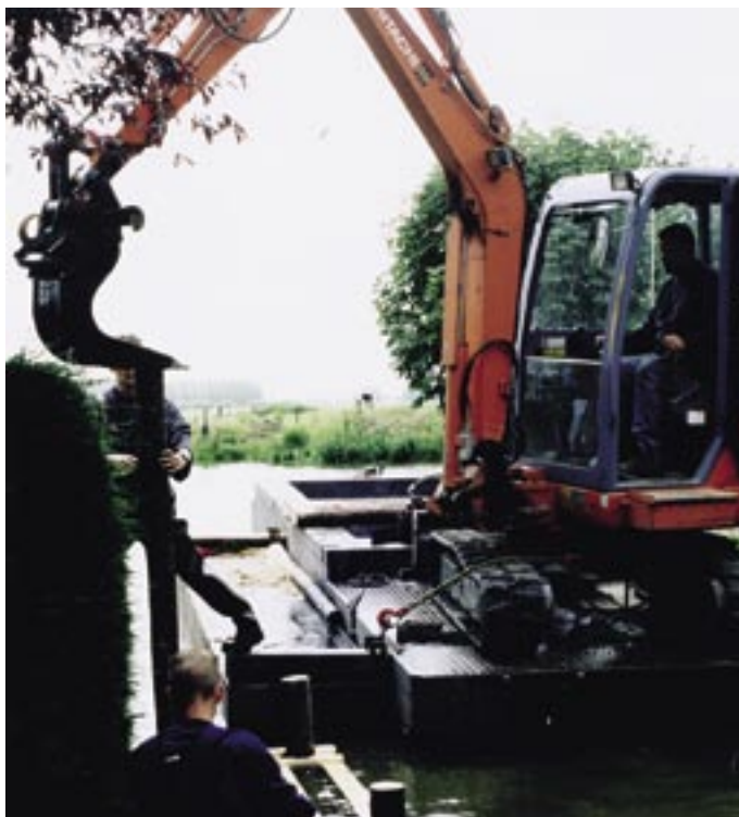
Juni 2002, plaatsen van de houten verankeringsspalen.
