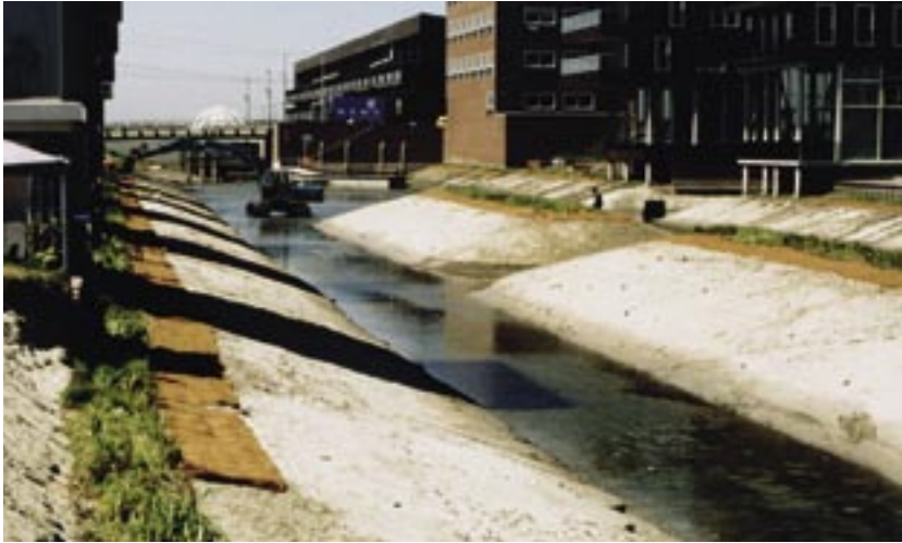
Mei 2004, de Aqua-Flora matten worden in den droge geïnstalleerd.
