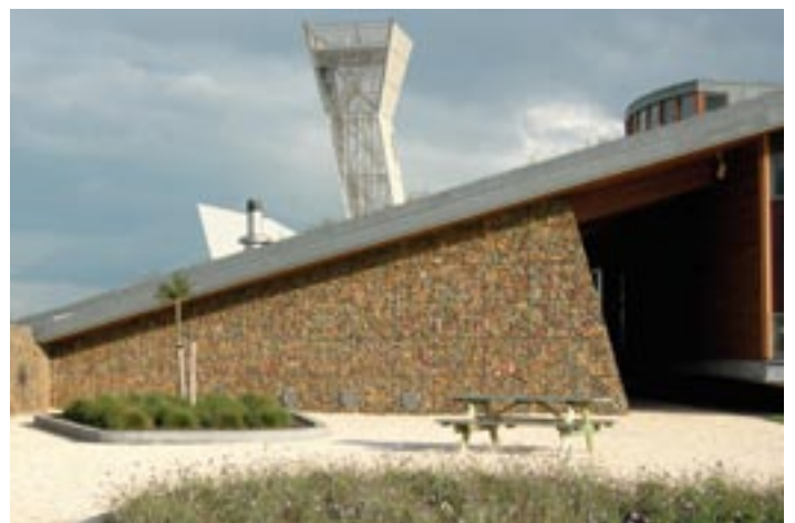
September 2006, gevel technische ruimte voltooid
