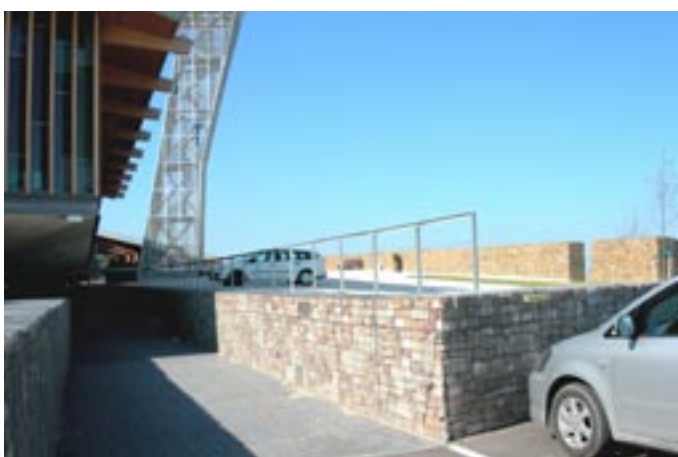
September 2006, overzicht schanskorven in uitrit p-garage
