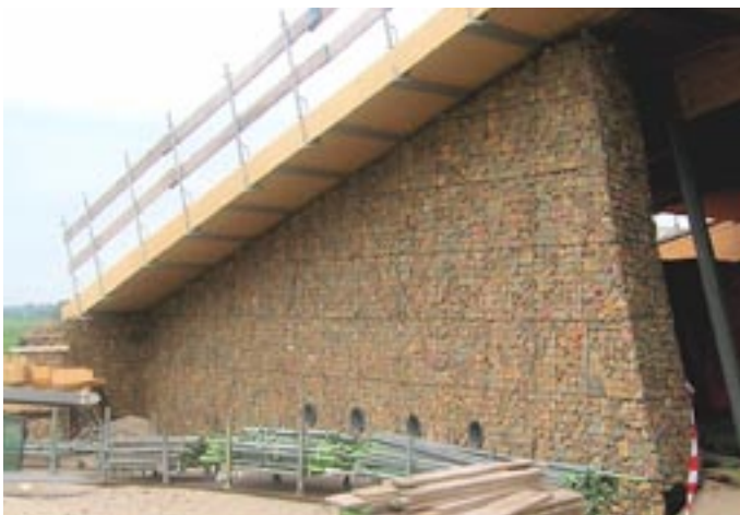
April/Mei 2005, gevel technische ruimte in aanbouw
