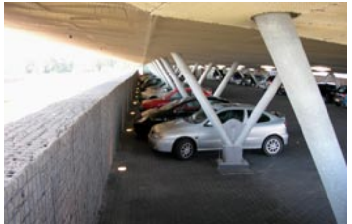
Sept. 2006, schanskorven als grondkering in souterrain p-garage
