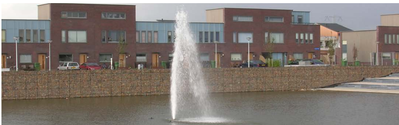
November 2005, werkzaamheden voltooid.
