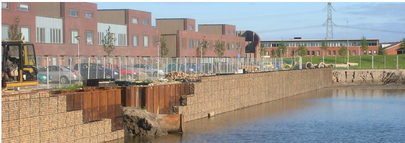
Augustus 2005, installatie bekleding stalen damwand met schanskorven.
