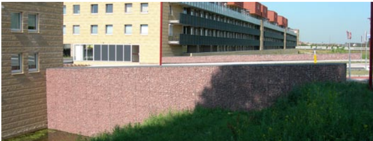
Juli 2006, de voltooide damwand-bekleding in schanskorven
