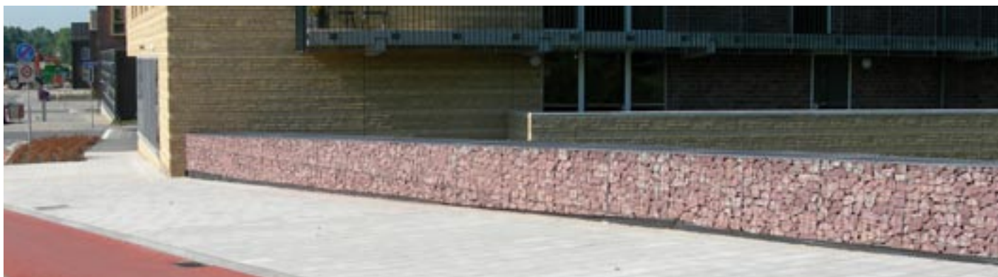
Juli 2006, zicht op de borstwering in schanskorven vanaf de ontsluitingsweg
